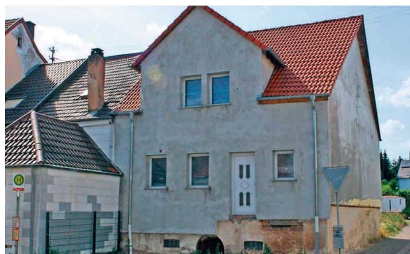
Ohne Treppe und Bewohner: Seit über einem Jahrzehnt steht dieses Haus in der Blickweiler Dorfmitte leer. FOTO: HANS HURTH
